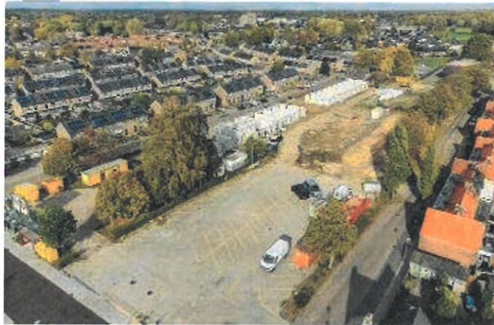
▲ Nu nog beton en zand, straks creëert's groen: de locatie voor het Spoorpark in Goor. De bouw van nieuwe woningen aan de Roerdompstraat is inmiddels begonnen. © Gemeente Hof van Twente
